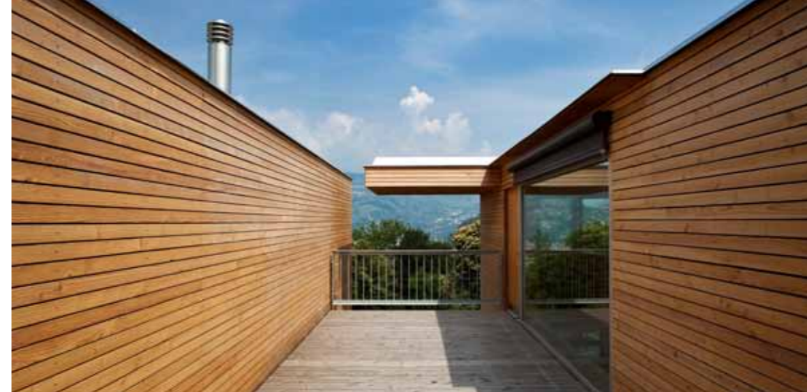
Konstruktiver Ingenieurholzbau verbindet High-Tech mit alter Tradition. Der hohe Vorfertigungsgrad von Holzbauten stellt auch hohe Qualität sicher. Die einzelnen Gebäudeelemente müssen auf der Baustelle nur noch versetzt werden. Lange Austrocknungszeiten entfallen.
