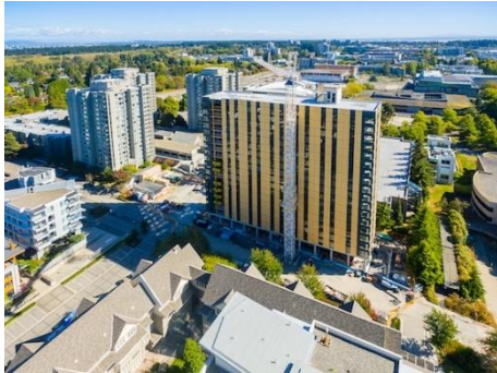
UBC Brock Commons, 18 Geschosse Standort: Vancouver, Kanada Architektur: Acton Ostry Architects Fertigstellung: 2017 © naturally wood
