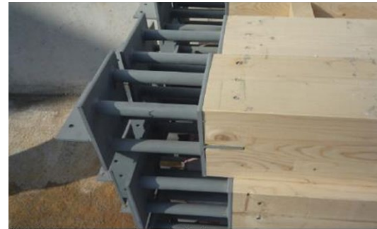
Id: Holzstützen mit vormontierten Stahlteilen.
