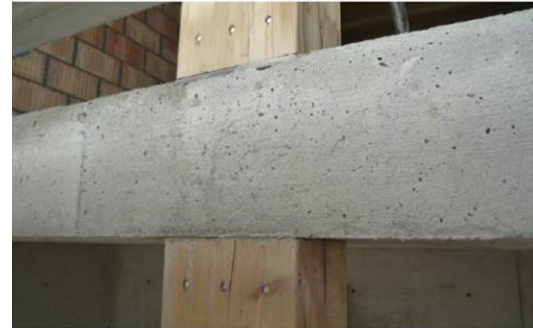
Bild: Stützen nach dem Ausschalen
