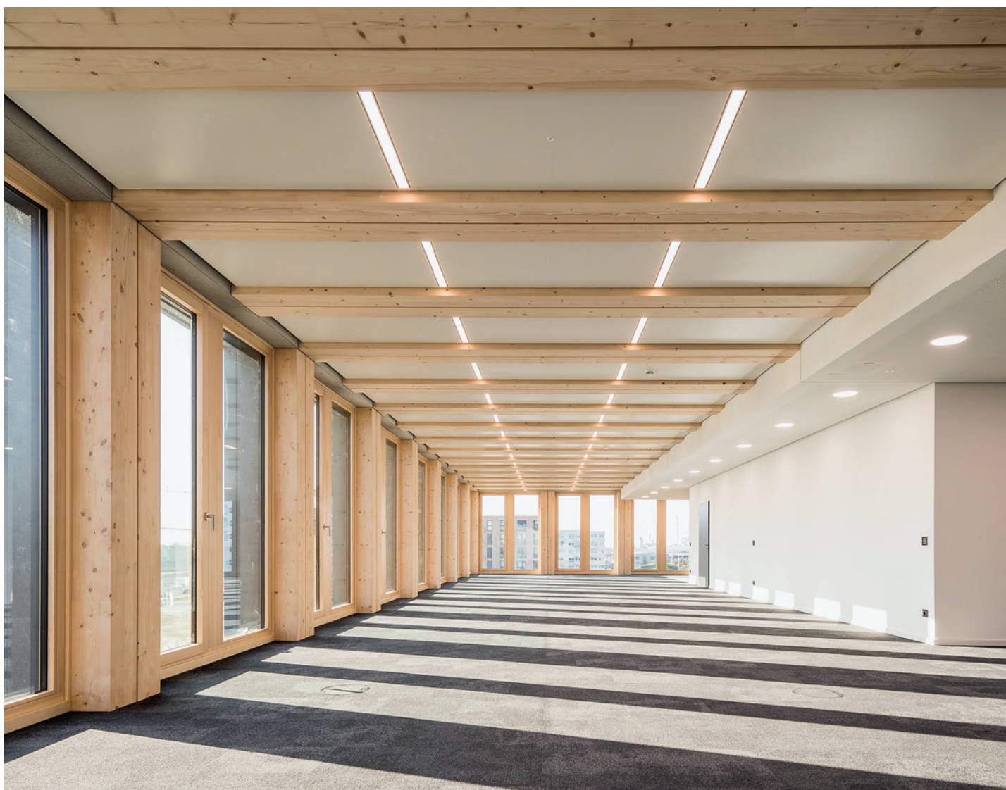
Nella Handwerkerhaus di Brema, la struttura portante in legno è stata lasciata a vista all'interno.
