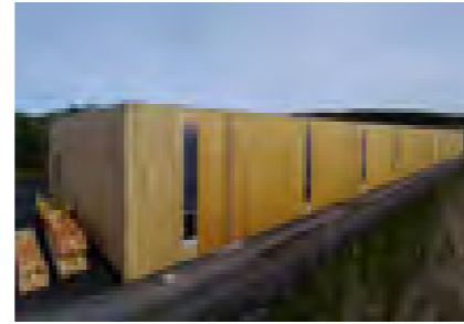
Sägewerk Burgbacher AuftraggeberIn: Holzwerk GmbH & Co KG Planung: Schneider Architekt BDA Holzbau: WIEHAG GmbH Foto: Thomas Riedel
