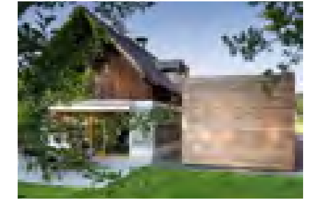
Zubau Hagenmühle AuftraggeberIn: Familie Molzbichler Planung: MHM architects Holzbau: Holzbau Bammer GmbH Foto: MHM architects
