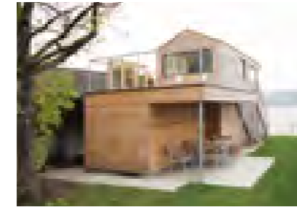
Bootshaus am Attersee AuftraggeberIn: Familie Ratschmann Planung: Prof. Kaufmann & Partner ZT GmbH Holzbau: Plonerbau GmbH Foto: Arch. DI Matthias Haas
