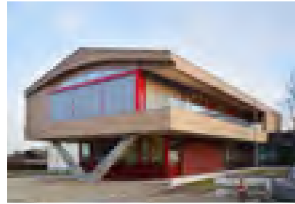
VS Pfaffstätt AuftraggeberIn: VFI der Gemeinde Pfaffstätt Planung: Kleboth Lindinger Dollnig ZT GmbH Holzbau: Bortenschlager Bauunternehmen GmbH Foto: Bortenschlager GmbH
