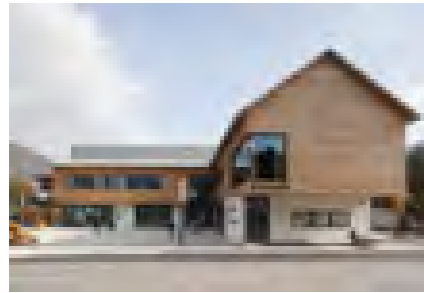
Gemeindeamt Grünau im Almtal AuftraggeberIn: Verein zur Förderung der Infrastruktur der Gemeinde Grünau im Almtal & Co KG Planung: Architekt Mag. Ing. Josef Königsmaier, Kienesberger Schröckenfuchs Architektur Holzbau: Stern & Hafferl Baugesellschaft mbH Foto: Andrew Phelps
