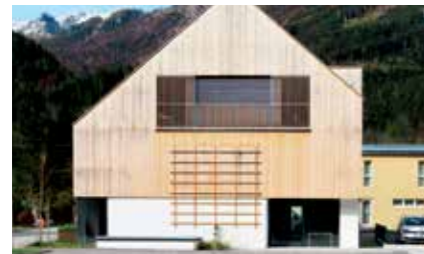
Co Housing Hinterstoder Auftraggeber: Freizeiteinrichtung GmbH Hinterstoder Planung: OZ Architektur – Mag.arch. Robert Oberbichler Holzbau: Josef Steindl Zimmermeister-Holzbau, Gesellschaft m.b.H.
