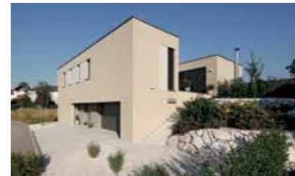
Haus Kammer am Attersee Auftraggeber: Privat Planung: bhe-architektur - Dipl.-Ing. Bernhard EGGL Holzbau: Stern & Hafferl Baugesellschaft m.b.H.
