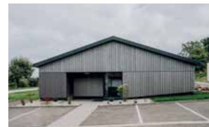
Haus der Gesundheit Adlwang Auftraggeber: Anton Aigner GmbH Planung: Kon-tur ZT GmbH Holzbau: Holzbau Aigner Gesellschaft m.b.H. – Zimmerei, Säge- & Hobelwerk
