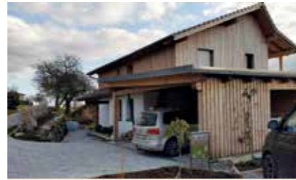
Ökologisches Strohballen-Holzriegel-EFM-Haus Böhm Auftraggeber: Privat Planung: Weglehner Holzbau GmbH Holzbau: Weglehner Holzbau GmbH
