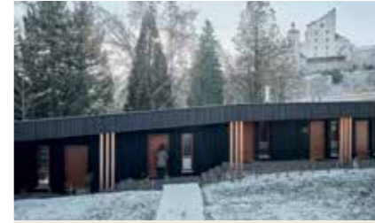
Clam Künstlergarderoben Auftraggeber: Clam Festival & Concerts Veranstaltungs GmbH Planung: x architekten ZT GmbH in Kooperation mit Atmo GmbH Holzbau: Luftensteiner GmbH
