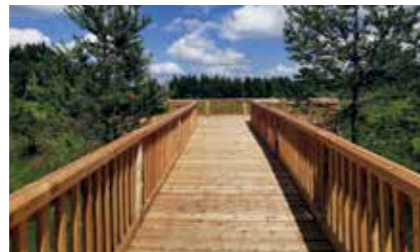
Kultur- und Naturerbe Schwarzenberger Schwemmkanal - BAYRISCHE AU Auftraggeber: Tourismusverband Ferienregion Böhmerwald Planung: arkade planungs gmbh - Planender BM Holzbau: BRÜDER RESCH HOCH- U. TIEFBAU GES.M.B.H. & CO.KG.
