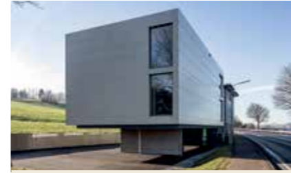
Bürogebäude ACC Auftraggeber: KM Immobilien GmbH Planung: neururer architekten zt gmbh Holzbau: Bau Pesendorfer G.m.b.H.
