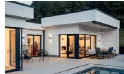
Haus Wellness - die Wohnose am Waldrand Auftraggeber: Privat Planung: Buchner Gesellschaft m.b.H. - Holzbaumeister Holzbau: Buchner Gesellschaft m.b.H. - Holzbaumeister
