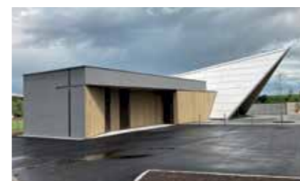
Aufbahrungshalle Kirchham Auftraggeber: Gemeinde Kirchham Planung: Mag.arch. Ing. Georg HOCHLEITNER Holzbau: Holzbau Amering GmbH
