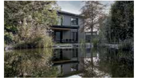
Haus ER Auftraggeber: ER Guitars Wels Planung: Dipl.-Ing. Georg HARANT-SCHILCHER Holzbau: Kapl Bau GmbH
