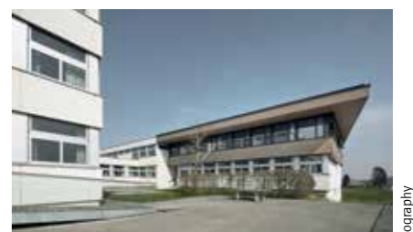
Erweiterung GYM Gmunden Auftraggeber: BIG Planung: ARGE Architekt Michael Kerschhofer & Architekt Dipl.-Ing. Philipp Stromer Holzbau: Stern & Hafferl Baugesellschaft m.b.H.
