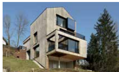
Turmhaus Auftraggeber: Privat Planung: HPSA ZT GmbH Holzbau: Stern & Hafferl Baugesellschaft m.b.H.
