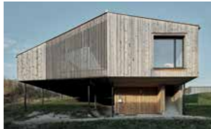
Kleines Haus mit Hang und Hof Auftraggeber: Privat Planung: Ing. Mag.arch. Klaus Michael Scheibl / HPSA ZT GmbH Holzbau: L.H. Holzbau GmbH
