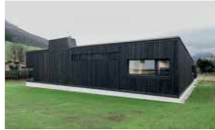
Atriumhaus S. Auftraggeber: Anton Aigner GmbH Planung: Steinkogler Aigner Architekten ZT GmbH Holzbau: Holzbau Aigner Gesellschaft m.b.H. – Zimmerei, Säge- & Hobelwerk
