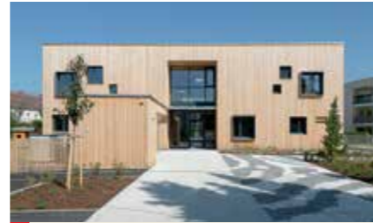
ENGERE WAHL Kinderbetreuungseinrichtung Feldstraße Ottensheim Auftraggeber: Marktgemeinde Ottensheim Planung: Architekt Stummer ZT GmbH Holzbau: BRÜDER RESCH HOCH- U. TIEFBAU GES.M.B.H. & CO.KG.
