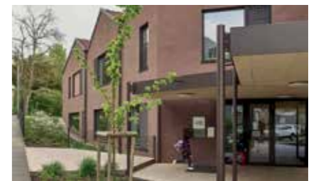
HORT Hauderweg Auftraggeber: Immobilien Linz GmbH Planung: mia2 ARCHITEKTUR ZT GmbH Holzbau: BRÜDER RESCH HOCH- U. TIEFBAU GES.M.B.H. & CO.KG.
