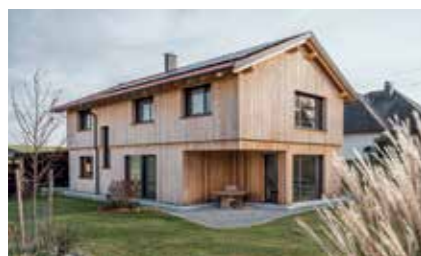
Wohnhaus Auftraggeber: Privat Planung: Kon-tur ZT GmbH Holzbau: Weißhaidinger Ingenieur-Holzbau GmbH
