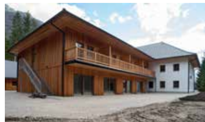
Konrad-Lorenz-Forschungsstelle Auftraggeber: Naturtierpark Grünaau GmbH Planung: Ing. Manfred Penninger Bau GmbH Holzbau: Wolf Systembau Gesellschaft m.b.H.
