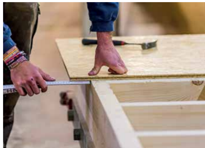
Holzbau-Meister fertigen Holzkonstruktionen im Werk millimetergenau vor.
