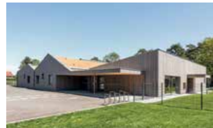
Kindergarten St. Martin 2 Auftraggeber: Stadt Traun Planung: klicarchitects ZT GmbH Holzbau: Eiblmayr - Wolfsegger Hoch- und Tiefbau GmbH
