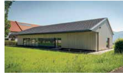
Musikheim Nussdorf Auftraggeber: Gemeinde Nußdorf a. A. Planung: neururer architekten zt gmbh Holzbau: Reindl Bau GmbH
