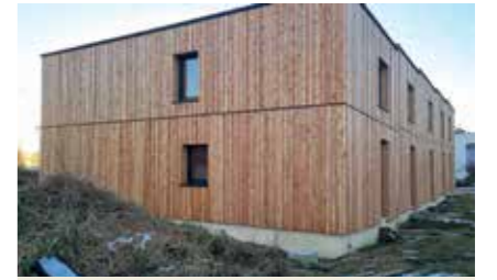
Woody 4 Auftraggeber: Enerquent Bauwerte GmbH Planung: Dipl.-Ing. Siegfried Diesemberger Holzbau: Holzbau Mitterbauer in Kooperation mit Leidorf
