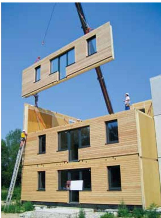
Abb.1.1.6 Montage Großtafelbau
