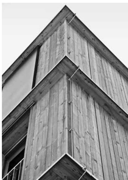
Abb. 2.3.7 Anwendungsbeispiel: Projekt Mühlweg Bauplatz A. Errichtung 2006, Grundprinzip der Brandschutzabschottung. Quelle: Holzforschung Austria und Arbeitsheft 8/06 - Brandschutztechnische Ausführung von Holzfassaden, proHolz Austria 2006
