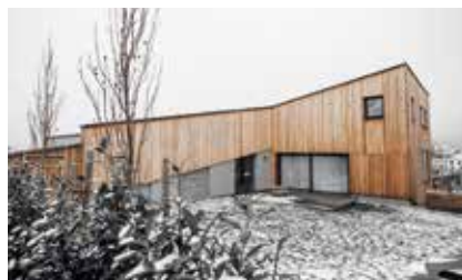
Dr. Scheuba-Grieskirchen Auftraggeberin: Dr. Scheuba Planung: DIPL. ING. PROF. WOLFGANG WIMMESBERGER-STAINER Holzbau: Duswald Bau GmbH - DUSWALD BAU
