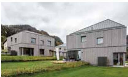
Doppelhäuser Pernzell Auftraggeberin: Anton Aigner GmbH Planung: Steinkogler Aigner Architekten ZT GmbH Holzbau: Holzbau Aigner GmbH
