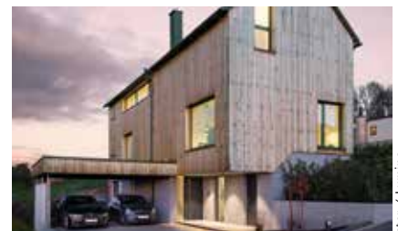
Das Haus mit Weitblick Auftraggeber: Katrin Kolp und Stefan Damm Planung: Arch. DI Richard Steger Holzbau: Buchner Gesellschaft m.b.H. - Holzbaumeister
