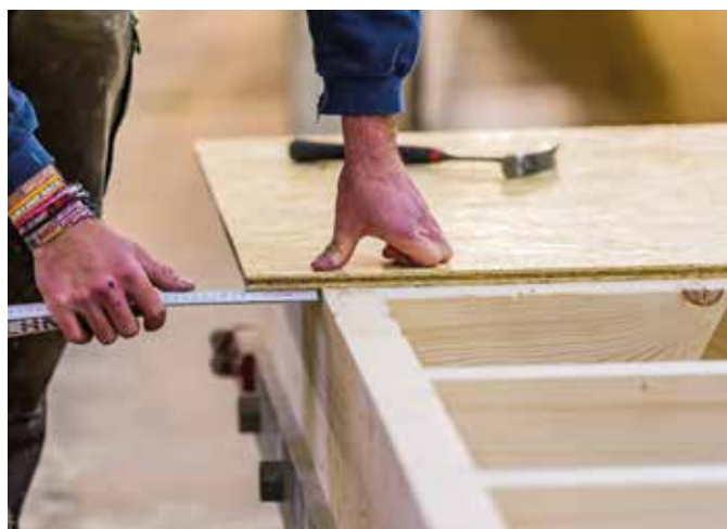
Holzbau-Meister fertigen Holzkonstruktionen im Werk millimetergenau vor.
