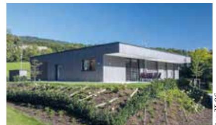
Einfamilienhaus Rastinger, Altmünster Auftraggeberin: Gabriele Rastinger Planung: Hinterwirth Architekten ZT OG Holzbau: Zeppetzauser Bau- und Zimmerei Gesellschaft m.b.H.
