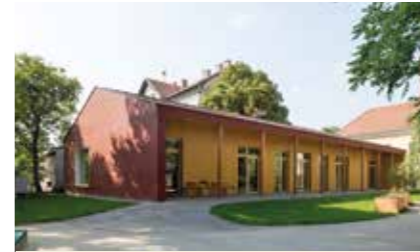
Kindergarten Linzerstraße, Wien Auftraggeber: Magistrat der Stadt Wien Planung: TC ZT GmbH Holzbau: Schmid Holzbau GmbH
