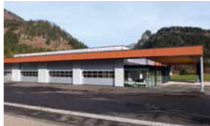
Erweiterung Busgarage Riedler Auftraggeberin: Riedler Reisen & Touristik GmbH Planung: Architekturbüro 1 ZT GmbH + Mag.arch. Robert Oberbichler Holzbau: Schoiswohl Baugesellschaft mbH
