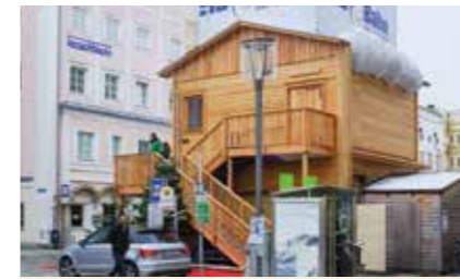
Neubau Bühne, mit Gastronomiebereich als Winterattraktion Auftraggeberin: Welser Christkind GmbH Planung: Huber Holzbau GmbH Holzbau: Huber Holzbau GmbH
