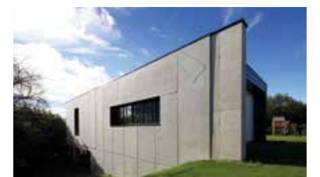
Lofthaus Linz Auftraggeberin: Familie Ortig Planung: Kleboth Lindinger Dollnig ZT GmbH Holzbau: SWIETELSKY Baugesellschaft mbH
