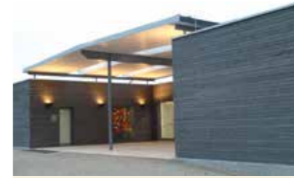
Pfarrzentrum Eggendorf Auftraggeberin: Pfarre Eggendorf Planung: DI Wolfgang Schaffer und DI Alfred Sturm Holzbau: Obermayr Holzkonstruktionen GmbH
