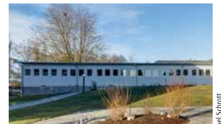
Temporäres Ersatzquartier Alten- und Pflegeheim Vöcklabruck Auftraggeberin: LAWOG - eingetr. Genossenschaft mbH Planung: Architekten: Gärtner + Neururer ZT GmbH Holzbau: Schmid Holzbau GmbH
