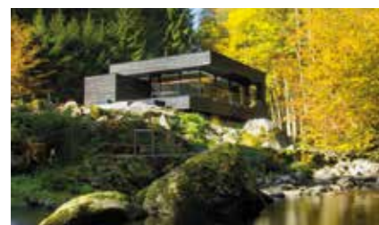
Haus am Fluss Auftraggeber: Mag. Gerd Schachermayr Planung: Arch. DI Helmut Siegel Holzbau: Obermayr Holzkonstruktionen GmbH
