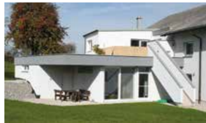
BVH Huber, Umbau und Zubau Auftraggeber: Anja und Engelbert Huber Planung: DI Erwin Stammler Holzbau: Vollhaus GmbH
