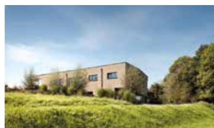
40_appr Auftraggeber: Mag. Angelika und Mag. Roland Chlibowycz Planung: udo heinrich architekten Holzbau: K. & J. Weixelbaumer Baumeister Betriebs-GmbH
