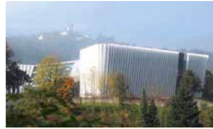
Anton Bruckner Privatuniversität Linz Auftraggeberin: BEG Bruckner-Universität Errichtungs- und Betriebsgesellschaft mbH Planung: Architekturbüro1 ZT GmbH Holzbau: Obermayr Holzkonstruktionen GmbH
