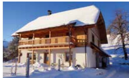
Zu- und Umbauarbeiten beim bestehenden Wohnhaus Auftraggeber: Norbert und Susanne Ebner Planung: Ing. Roland Kretschmer Baumeister und Zimmermeister GmbH Holzbau: Ing. Roland Kretschmer Baumeister und Zimmermeister GmbH
