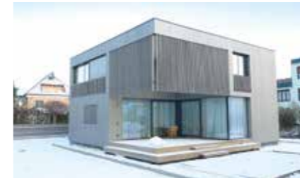
Einfamilienhaus Hartwig Auftraggeber: Ulrich Hartwig Planung: Arch. DI Christa Lepschi Holzbau: Franz Aichinger Hoch-, Tief- und Holz- bau GmbH & Co Nfg KG
