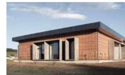
Abfallsammelzentrum Perg / Büro BAV Perg Auftraggeber: Bezirksabfallverband Perg Planung: exp architekten ZT GmbH Holzbau: Krückl Baugesellschaft mbH & Co KG
