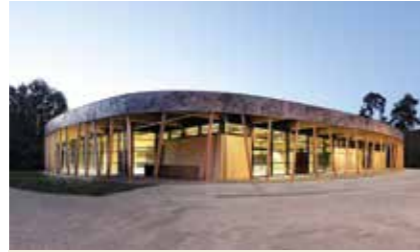
Sporthalle Seeheim Auftraggeber: Da-Di-Werk Gebäudemanagement des Landkreises Darmstadt-Dieburg Planung: LOEWER + PARTNER ARCHITEKTEN Holzbau: WIEHAG GmbH
