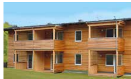
Wohnhausanlage Steinbach/ Ziehberg Auftraggeberin und Planung: OÖ Wohnbau Gesellschaft für den Wohnungsbaugemeinnützige GmbH Holzbau: Holzbau Bammer GmbH
