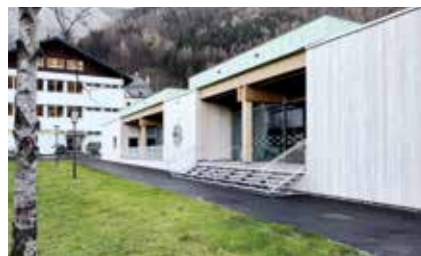
HTBLA Hallstatt Bauteil Werkstatt W4 Auftraggeberin: Bundesimmobiliengesellschaft mbH Planung: riccione architekten Holzbau: Weißhaidinger Ingenieur-Holzbau GmbH
