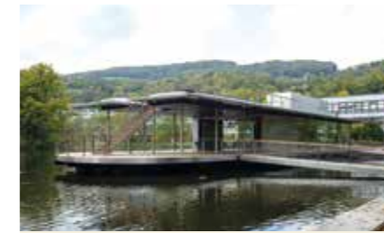
Teichwerk - Schwimm-Pavillon Johannes-Kepler-Universität/ Linz Auftraggeberin: JKU Betriebs- und Vermietungs- GmbH Planung: Architekten Luger & Maul ZT GmbH Holzbau: Obermayr Holzkonstruktionen GmbH
