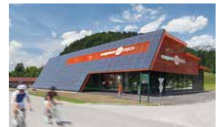
Neubau eines Betriebsgebäudes Auftraggeberin: E-Holding GmbH Planung: Kleboth Lindinger Dollnig ZT GmbH Holzbau: Obermayr Holzkonstruktionen GmbH
