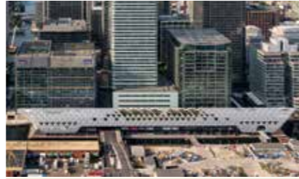
Canary Wharf Crossrail Station Feature Roof Auftraggeber: Canary Wharf Contractors Ltd. Planung: Foster + Partners Holzbau: WIEHAG GmbH
