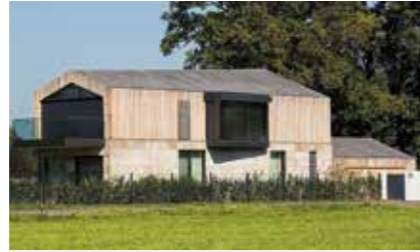
Angel House Auftraggeber: Gansbühler Planung: Raumbau Architekten ZT GmbH Holzbau: Zenz Holzbau GmbH
