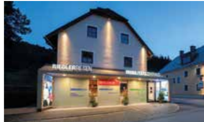
Mobilitätszentrale Riedler Reisen Auftraggeberin: Riedler Reisen & Touristik GmbH Planung: Architekturbüro 1 ZT GmbH + Mag.arch. Robert Oberbichler Holzbau: Schoiswohl Baugesellschaft mbH
