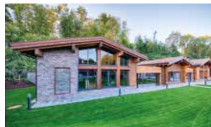
Eurothermen Resort Bad Schallerbach „Chalets“ Auftraggeberin: Eurothermen Resort Bad Schallerbach GmbH Planung: Architekten Zellinger Gunhold und Partner ZT GesmbH Holzbau: Duswald Bau GmbH
