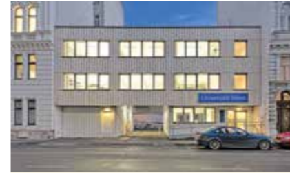
Temporäres Bürogebäude Sensengasse 6 Wien Auftraggeberin: Universität Wien Planung: Kirsch ZT GmbH Holzbau: Schmid Holzbau GmbH
