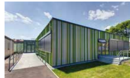
Zubau Schule 23, Baslergasse 43 Auftraggeber: Magistrat der Stadt Wien Planung: Kirsch ZT GmbH Holzbau: Schmid Holzbau GmbH
