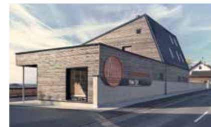
Pfarrzentrum St. Willibald Auftraggeberin: Pfarre Sankt Willibald Planung: Architekturbüro ARKADE ZT GmbH Holzbau: HAUER Zimmerei GmbH
