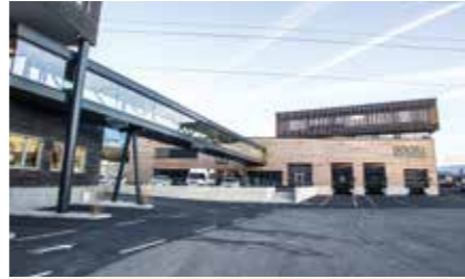
Neubau Büro und Lagerhalle Fa. Isocell Auftraggeberin: ISOCELL GmbH Planung: Industriebauzone GmbH Holzbau: Franz Aichinger Hoch-, Tief- und Holzbau GmbH & Co Nfg KG
