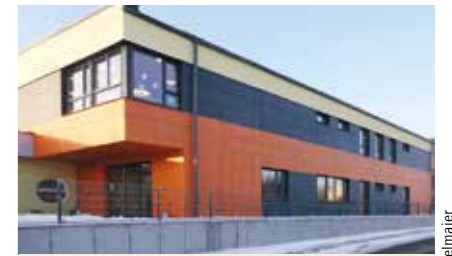
Zubau Kindergarten Brunnenthal Auftraggeberin: Gemeinde Brunnenthal Planung: Arch. DI Wolfgang Sedelmaier Holzbau: Weißhaidinger Ingenieur-Holzbau GmbH
