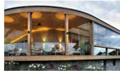
„Sky Lounge“ und „Franz“ Auftraggeberin: Hotel Gmchl GmbH Planung: Planungsbüro Martin Wieland GmbH Holzbau: Zenz Holzbau GmbH
