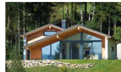
Neubau eines Ferienhauses Auftraggeber: Sonja und Andreas Martin Planung: Brüder Resch Hoch- u. Tiefbau GmbH & Co KG Holzbau: Brüder Resch Hoch- u. Tiefbau GmbH & Co KG
