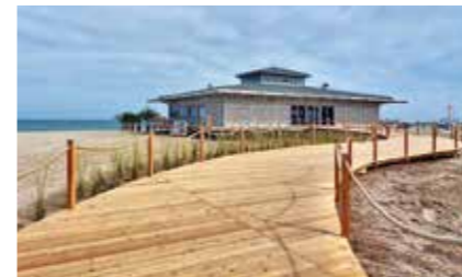
Ganvie Beach Club Bulgarien Auftraggeberin: Albena AG Planung: Huber Holzbau GmbH / Christian Bogner GmbH - Living Art Holzbau: Huber Holzbau GmbH
