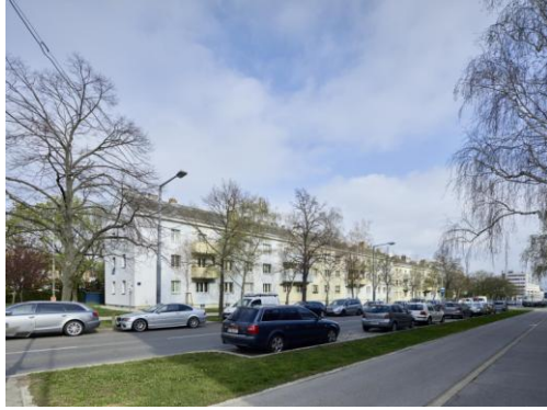
proHolz Student Trophy 2020, Bestandswohnbau 1 Wohnhausanlage Maroltingergasse 19-25 (Stiege 6-10), 1160 Wien. Freistehende Zeilenbebauung, Baujahr 1960, 99 Wohnungen im Bestand. © proHolz Austria, Bruno Klomfar
