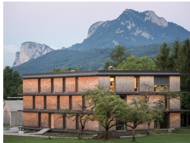
Bürogebäude oh456, Thalgau (2014)
