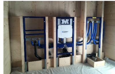
Quelle: TU Graz, Institut für Hochbau. 2020
