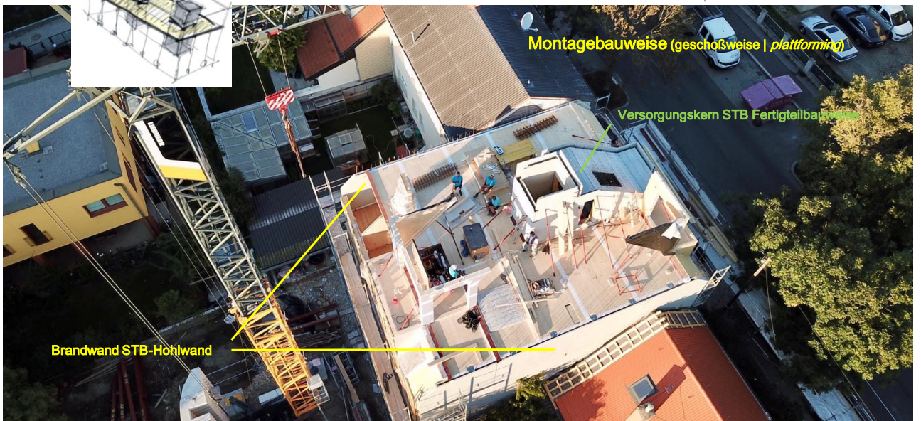
Brandwand In STB | Jedlersdorfer Strasse, Wien STB Hohlwand + Brettsper Holzdecke sicht
