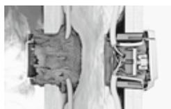
Abb. 20 c: Kompensation mit Hohlwanddose mit Dämmschichtbildner
