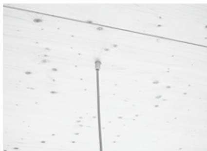
Abb. 22 und 23: Elektroleitungsführungen bei sichtbarer Brettsper Holzdecke werden von oben zugeführt und sind luftdicht auszuführen
