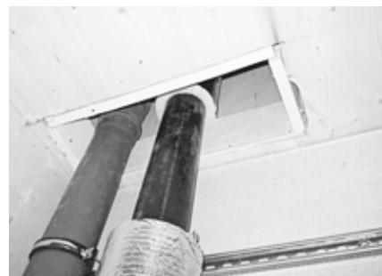
Abb. 28: Nicht vollflächiger Einbau der Leibungsverkleidung; rechts liegt die Schachtverkleidung nicht durchgehend an der Deckenkante an
