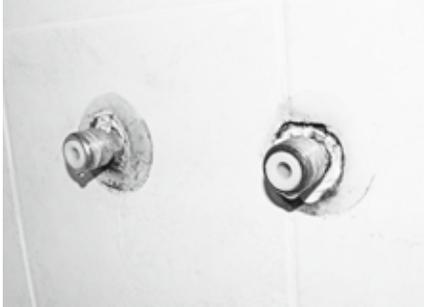
Abb. 35 und 36: Nicht abgedichtete Armaturdurchdringungen als Ursache von Feuchteschäden
