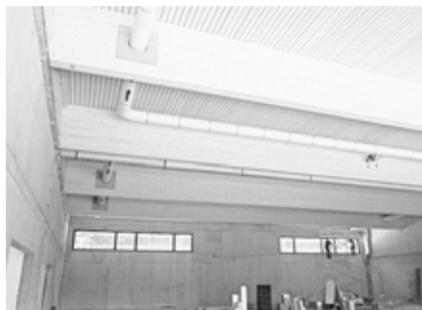
Abb. 5: Verstärkter Trägerdurchbruch
