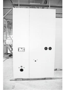
Abb. 8 und 9: Vorgefertigte Installationswand für Feuchtraum (wc, Waschbecken und Duschanschluss)
