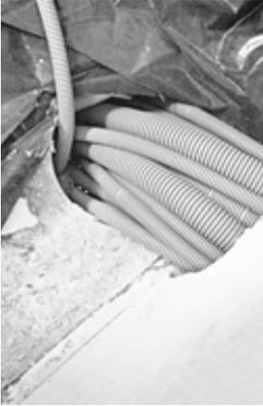
Abb. 7: Durchdringungen bilden eine Herausforderung an die Luftdichtheit zwischen den einzelnen Wohnungseinheiten
