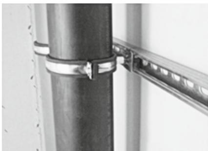
Abb. 32: Schallschutztechnische Entkoppelung der Rohre
