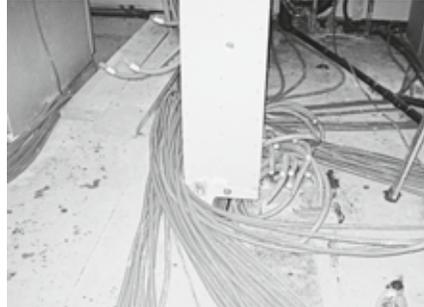
Abb. 18 und 19: Verlegung der Elektroerverrohrungen im Bereich des Fußbodenaufbaus (links: unkoordiniert, rechts: geplant und übersichtlich)
