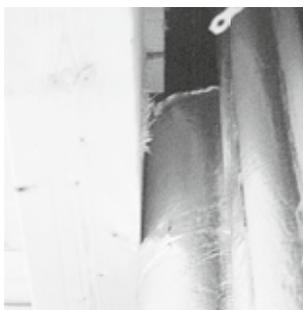
Abb. 31: Aufgrund nachträglicher Vergrößerung des Schachtes ist innenseitig keine nicht brennbare Bekleidung des hölzernen Unterzuges möglich. Aufwändige Sonderlösungen sind erforderlich.
