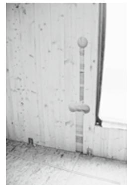
Abb. 16: Einfräsung von Elektroleitungen in Brettsperrholzwänden
