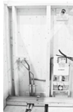
Abb. 10 und 11: Vorfertigung der Haustechnik in der Modulbauweise
