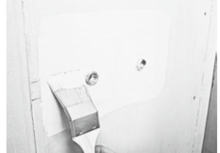
Abb. 37: Korrekt abgedichtete Ausführung von Armaturdurchdringungen
