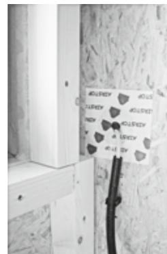
Abb. 15: Luftdichte Ausbildung einer Kabeldurchdringung durch die Außenwand
