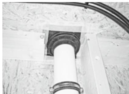
Abb. 24: Fachgerechte Abdichtung der Durchdringung mit Hilfe einer geeigneten Manschette
